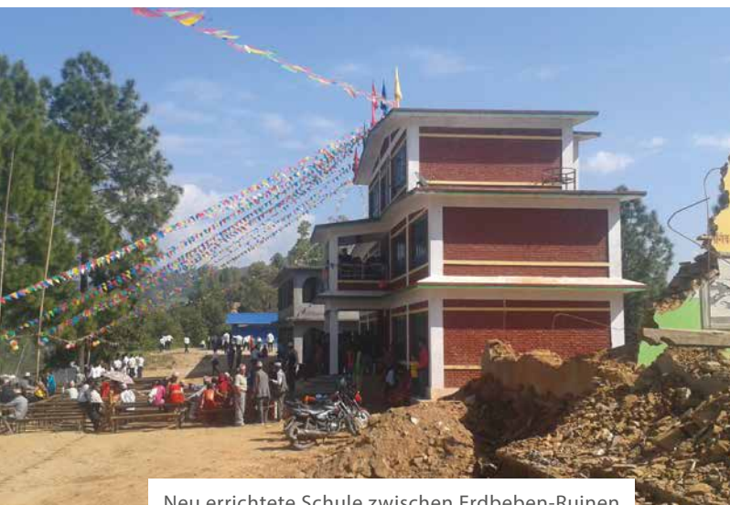
Neu errichtete Schule zwischen Erdbeben-Ruinen
